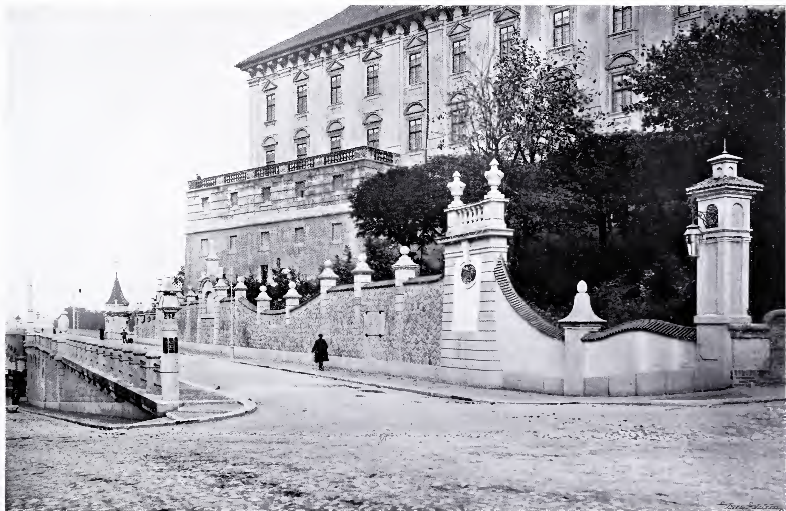
NOVÝ MOST PŘES LABE V ROUDNICI. -- SCHODIŠTĚ A RAMPA PŘI ZÁMKU. Architektonická úprava od arch. prof. J. Sandera.
